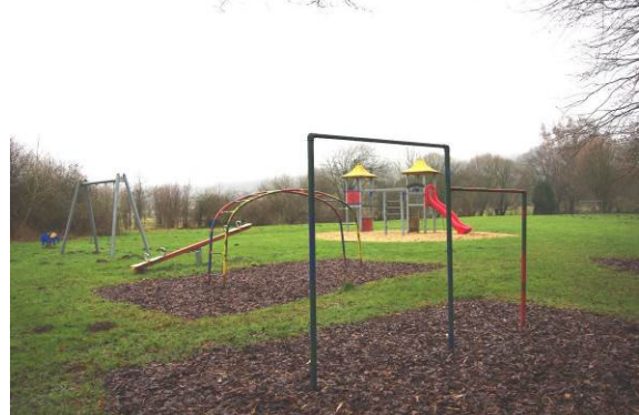
Der am Ockenser Bach gelegene Spiel- und Bolzplatz weist einige abgängige Geräte sowie wenig Aufenthaltsmobiliar auf.
