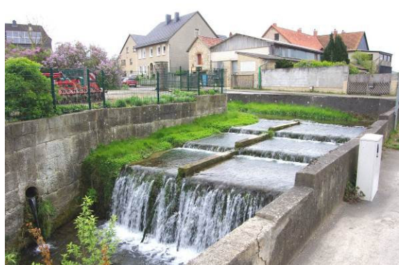
Die sog. Wassertreppe stellt einen innerörtlichen Sohlabsturz des Bachlaufes dar, das als Betonbauwerk gefasst ist.
