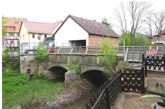
Die Sanierungsarbeiten an der als Baudenkmal geschützten historischen Brücke in der Bachstraße stehen vor dem Abschluss.
