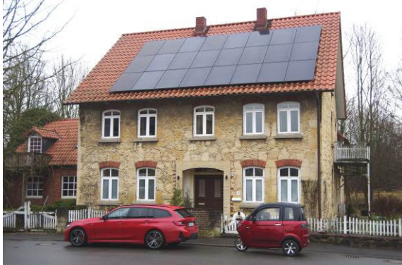
Bei Dacherneuerungen ist die mittlerweile gem. NBaUO bestehende Pflicht zur Errichtung einer PV-Anlage zu berücksichtigen. Gestalterisch gut integriert stellt sich diese Anlage dar.
