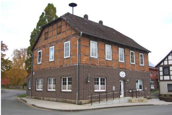
Das Dorfgemeinschaftshaus in Ockensen wurde Anfang der 1970er Jahre aus der ehem. Dorfschule entwickelt. Hier stehen bauliche und funktionale Aufwertungen an.
