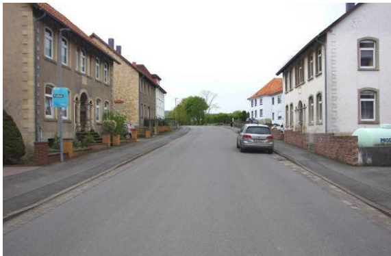
Innerörtlich sind die überregionalen Verkehrswege (hier K 11 in Thüste) vielfach durch große Fahrbahnbreiten, fehlende Gliederungen und eine umfangreiche Versiegelung gekennzeichnet.
