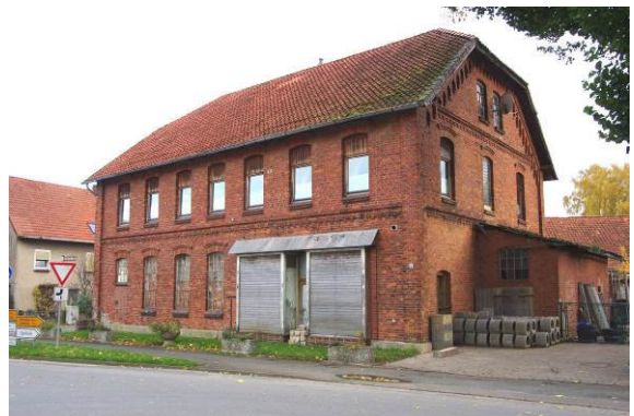
Die durch die traditionellen Gebäude geprägten Ortsbilder werden durch einige leerstehende oder abgängige Objekte erheblich beeinträchtigt.
