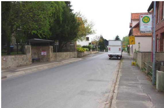
Die Nebenanlagen in der Angerstraße (L 463) weisen Erneuerungsbedarf auf. Die Bushaltestelle auf der südlichen Seite soll in den Bereich des Sommermarktplatzes verlegt werden.
