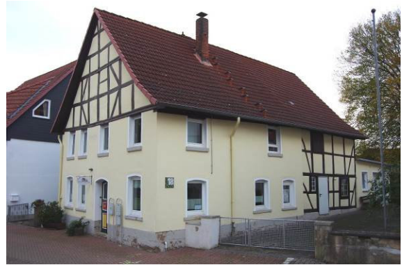
Das denkmalgeschützte Haus an der Stadtmauer dient seit 2011 der kulturellen Begegnung und wird vom Verein DorfKulTour betrieben.
