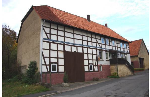
Zahlreiche ehem. landwirtschaftlich genutzte Gebäude(-teile) bieten Potential für eine Umnutzung. Dabei können auch der Innenraum und die Versorgung mit gefördert werden.
