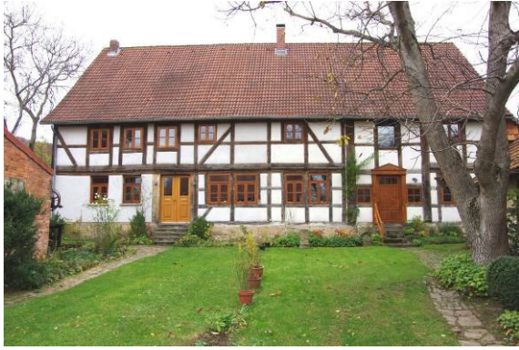
Weitgehend im bauzeitlichen Bild erhalten steht dieser zweigeschossige Fachwerkbau mit steilem Satteldach unter Denkmalschutz.
