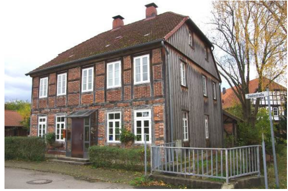
Aufgrund seines überlieferten Baubildes, aber auch aufgrund seiner Lage erweist sich dieser Fachwerkbau als ortsbildprägend.
