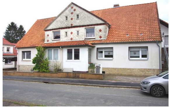
Das ursprüngliche Baubild entscheidet über die zu beachtenden gestalterischen Maßgaben – auch die Häuser der Bergmannssiedlung sind förderfähig.
