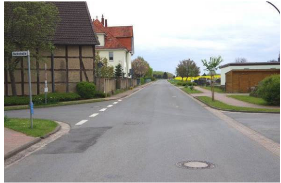
Geradlinig und mit leichtem Gefälle führt die L 463 aus südöstlicher Richtung nach Wallensen hinein, so dass auch die Straße Obertor durch Verkehrsgefährdungen gekennzeichnet ist.
