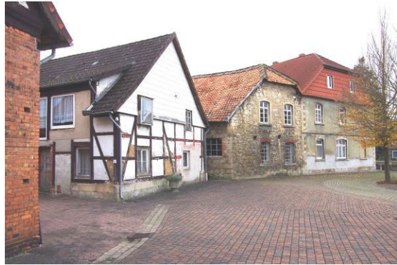
Zahlreiche der den Dorfplatz umgebenden Gebäude weisen bauliche Schäden bzw. einen dringenden Sanierungsbedarf auf.
