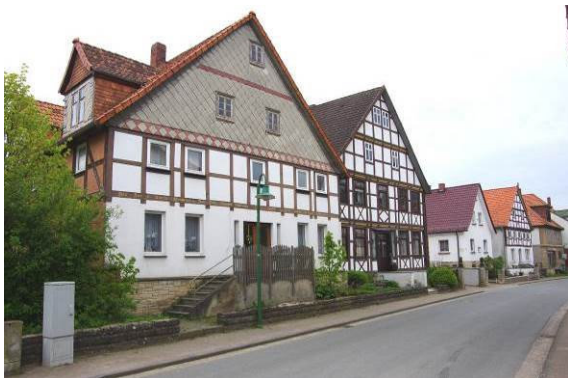
In der eng gestellten Abfolge von überwiegend giebelständigen zweigeschossigen Altbauten repräsentiert sich die städtische Vergangenheit.
