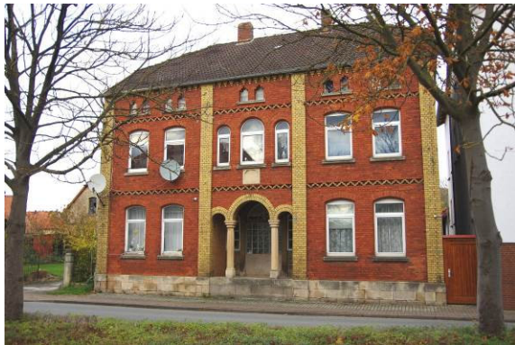
Ab dem ausgehenden 19. Jh. wurde die Fachwerkbauweise zunehmend durch massive Ziegelbauten abgelöst, die teilweise sehr repräsentativ ausgeführt wurden.
